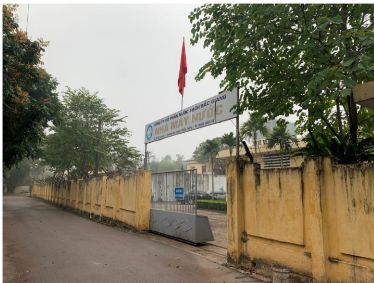
Nhà máy cấp nước thành phố Bắc Giang
