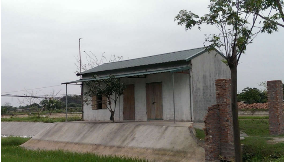
NHÀ MỘT TẦNG CÓ CỘT BÊ TÔNG CỐT THÉP, TƯỜNG GẠCH VÀ MÁI LỢP TÔN
