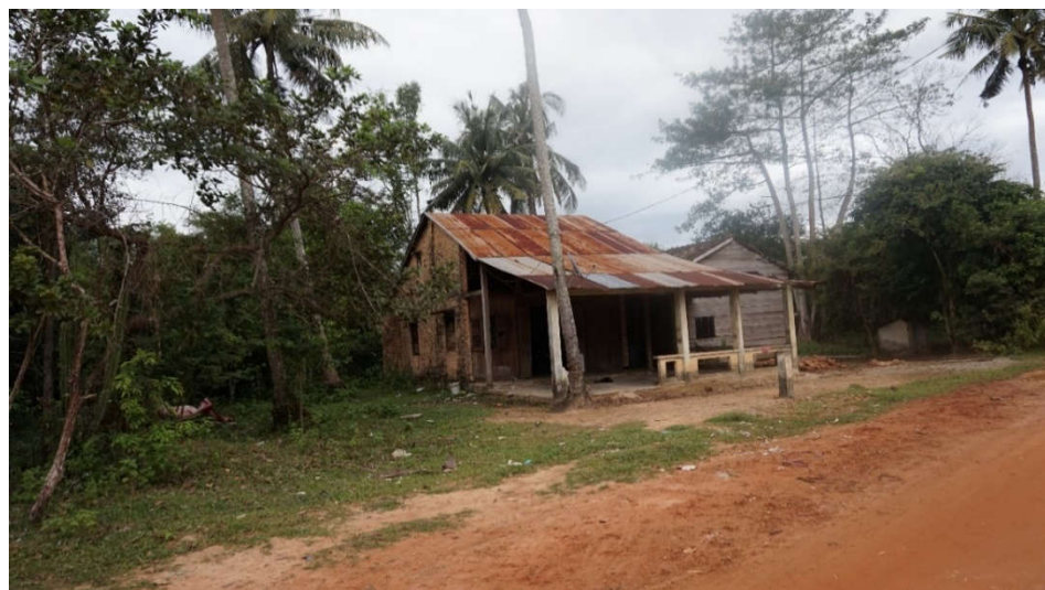
NHÀ MỘT TẦNG CHỈ CÓ TƯỜNG XÂY GẠCH BỀN CHẮC, KHÔNG CÓ CỘT, MÁI LỢP TÔN
