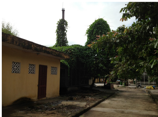
Lò đốt BVĐK tỉnh Bắc Giang
